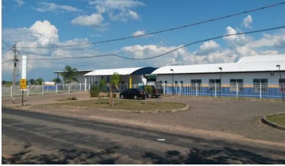
Foto 9 - Frente da atual EMEFNSN
